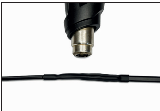
3.10. Поверх з'єднаних дротів надягнути термозбіжну трубку довжиною 150 мм та усадити її феном.
